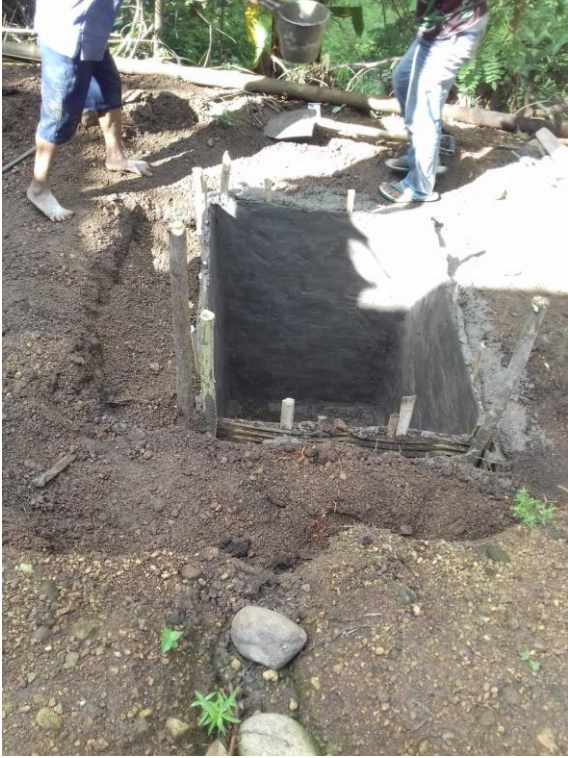
De matten worden aangesmeerd met cement.
